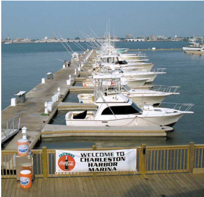
SF 500 mit Betonausleger, Charleston, USA
